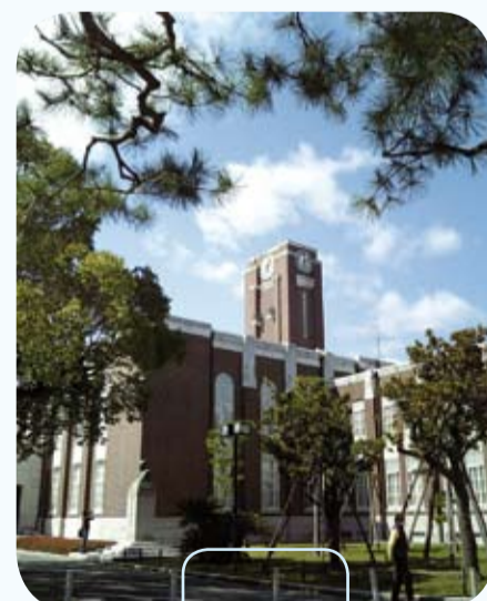
L'Université de Kyoto dispose du plus grand centre de liquéfaction d'hélium du Japon. Kyoto University has the biggest helium liquefaction centre in Japan.
