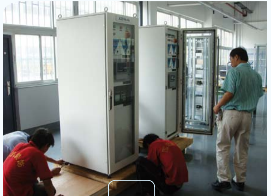
En 2009, TianMa avait déjà acquis une baie d'analyse CQC pour son usine de Chengdu. Ici, en cours d'installation. In 2009, Tianma had already acquired a CQC analysis bay for its plant in Chengdu. Here being installed.
